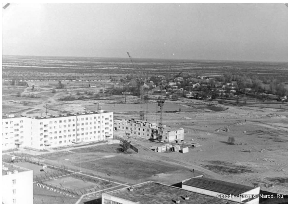
Figura 2: Vista aérea da construção do Estádio Avanhard. 1985 - Fonte: Reprodução Internet
