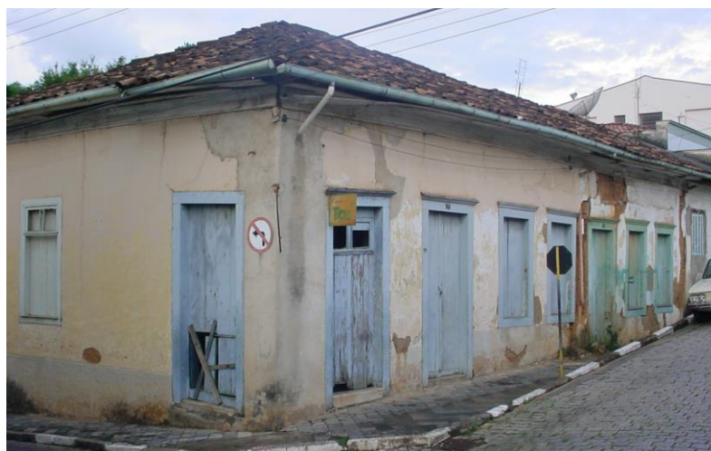
Imagem 1 - Edifício, em taipa, antes da restauração.
